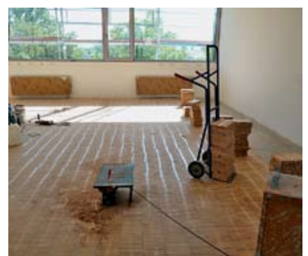
... der Boden verlegt.
