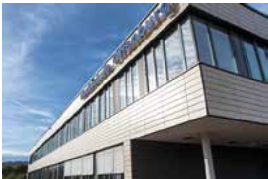
Das Hochschulgebäude auf dem neuen Bildungscampus
